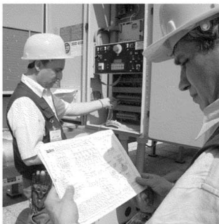
Nelle immagini, tecnici al lavoro in un cantiere
