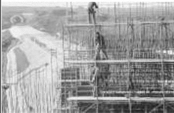
Diventano obbligatori i corsi di formazione per coloro che si apprestano a lavorare in un cantiere
